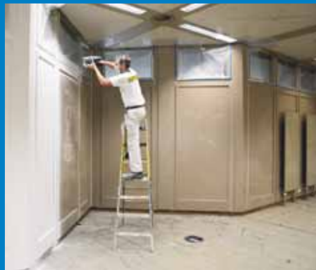
Beschichten der Kassettenfelder: Zunächst werden die umlaufenden Rahmenelemente lackiert ...
