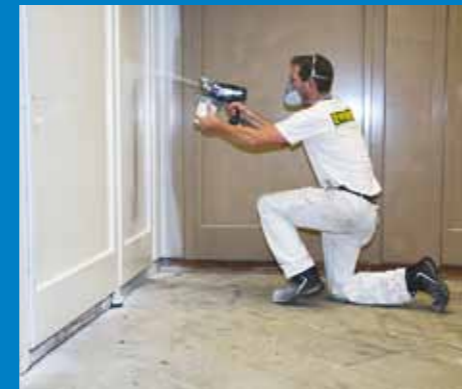
Positionswechsel: Wegen der Raumhöhe muss im unteren Bereich erneut angesetzt werden
