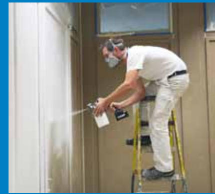
... und dann die innenliegenden Flächen beschichtet – es wird nur waagrecht oder senkrecht gespritzt
